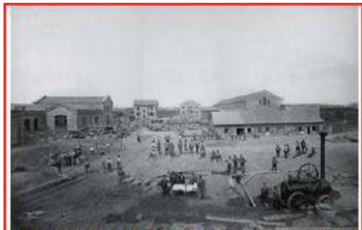
Bau des Gaswerkes (Neckarauer Übergang) 1876, StadtA Mannheim
